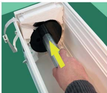
Postavite osovinu s trakom na predviđenu stranu
