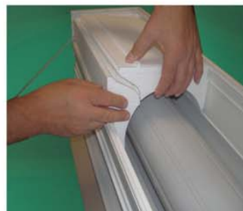
Ugradite izolaciju u kutiju
