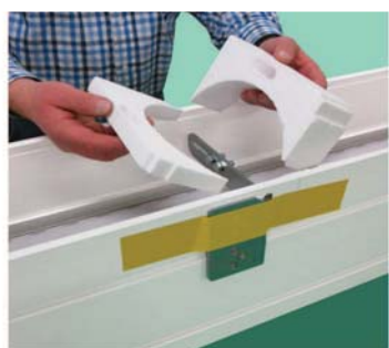
Dämmstücke für Statikkonsole in Rollladenkasten einsetzen Izolacijske komade za statičku konzolu staviti u kutiju
