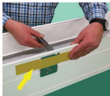
Konsole mit Klebeband an Deckelblende fixieren
