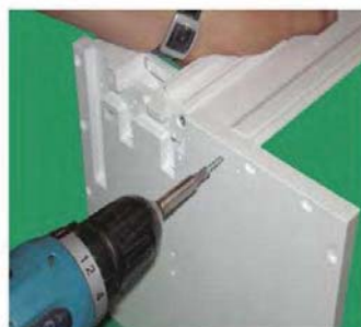
Kopfstücke mit Basisbrett verschrauben
