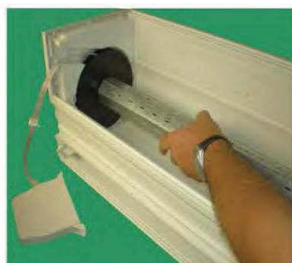
Gegenseite mit Gurtscheibe in Lagerscheibe einsetzen
