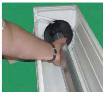
Welle mit Gurtscheibe in RK einsetzen
