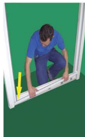
U-Schiene unten in Klemm- stücke einsetzen
