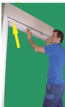
U-Schiene oben in Klemm- stücke einsetzen
