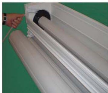
Fiksirajte lamele roletne za osovину i uvucite roletnu u kutiju
