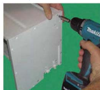
Kopfstücke mit Blenden verschrauben
