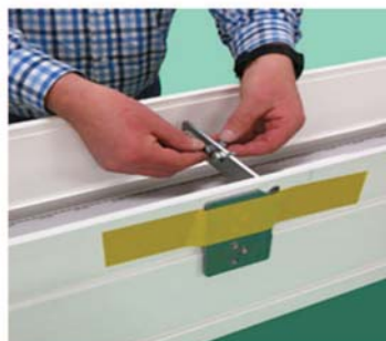
vorhandene Schrauben in Konsole eindrehen
