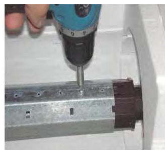
Walzenkapsel mit Welle verschrauben
