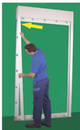
Adapter auf Klemmstücke am Blendrahmen aufschieben
