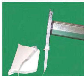
Gurt mit Gurtdurchführung an Gurtscheibe befestigen
