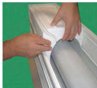
Dämmung in RK einsetzen
