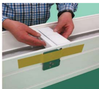
Dämmstücke für Statikkonsole in Rollladenkasten einsetzen Izolacijske komade za statičku konzolu staviti u kutiju
