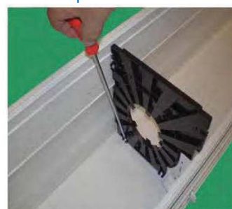
Doppelkopfstück beidseitig im RK verschrauben (3,9 X 9,5)
