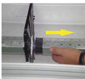
Welle teleskopieren
