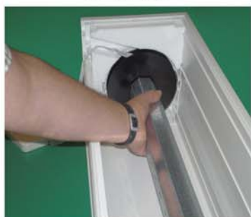
Postavite osovину sa trakom na predviđenu stranu
