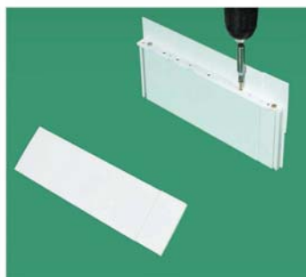
verschrauben oder verkeben der Winkelabdeckung mit der Außenblende Zavijanje ili lijepljenje kutnih poklopaca s vanjskom blendom
