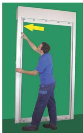
IS Türkassette oben in Adapter einrasten
