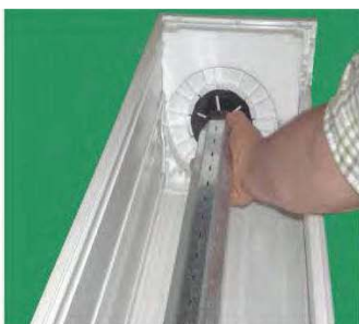
Gegenüberliegende Walzenkapsel teleskopieren
