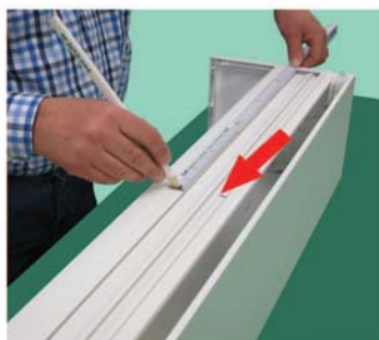
Position der Statikkonsole auf Basisbrett und Deckelblende anzeichnen Zabilježiti položaj statičke konzole na osnovnu dasku i blendu poklopca
