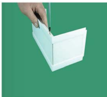
verschrauben der Winkelabdeckung mit den Innenblenden
