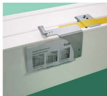
Dämmstücke für Statikkonsole in Rollladenkasten einsetzen Izolacijske komade za statičku konzolu staviti u kutiju
