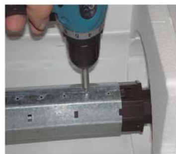
Zašarafite valjak za osovину
