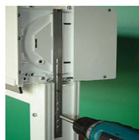
Učvrstiti bočnim limovima kutiju za prozor (samo veće raspone)
