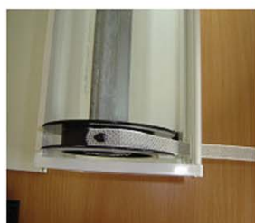
Provučemo kaiš kroz uvodnik i spojimo sa gurtšajbom i zašarafimo
