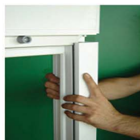
Vodilicu klipsamo na već postavljene šarafe
