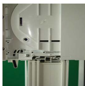
Kompletnu kutiju klipsati na već postavljene adapter na prozoru
